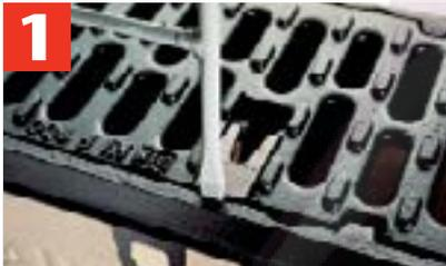
1 Para abrir el PowerLok, inserte herramienta entre la rejilla y el dispositivo PowerLok.
