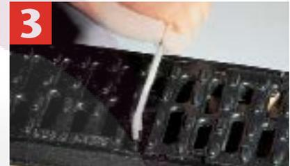
3 Para cerrar, coloque el gancho de la herramienta en la "V" y empuje hacia el riel.
