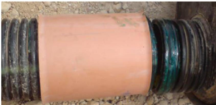
Posteriormente deslizar el accesorio suavemente hasta que tope con el empaque de valle colocado en el extremo
