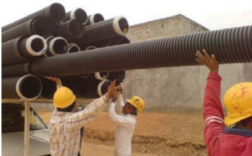
La descarga de tubería hasta 18" Ø (45 cm) puede realizarse de forma manual
