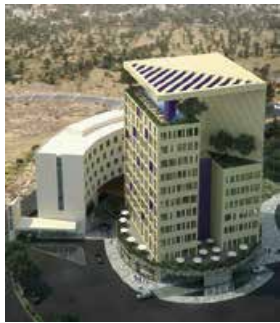
FORO 4 / EN EJECUCIÓN 2018, León Guanajuato
