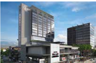
PLAZA MÉXICO / EN EJECUCIÓN 2018, San Luis Potosí
