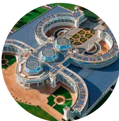
Sede social Challenger, Bouygues Construction, París
