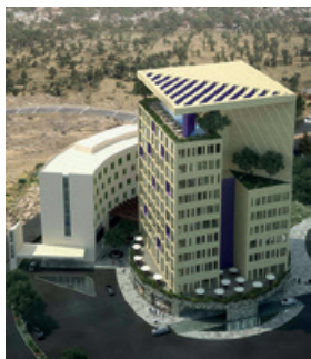
FORO 4 / EN EJECUCIÓN 2018, León Guanajuato
