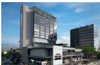
PLAZA MÉXICO / EN EJECUCIÓN 2018, San Luis Potosí
