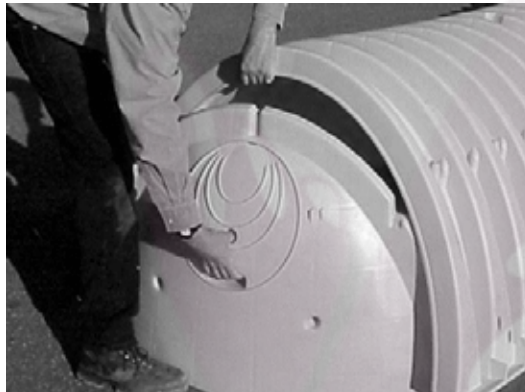
Figura 2. Colocación de las tapas
