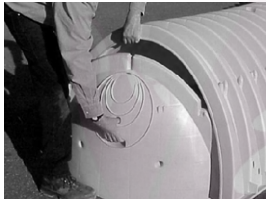
Figura 2. Colocación de las tapas
