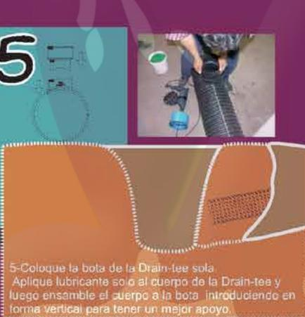
5-Coloque la bota de la Drain-tee sola. Aplique lubricante solo al cuerpo de la Drain-tee y luego ensamble el cuerpo a la bota introduciendo en forma vertical para tener un mejor apoyo.
