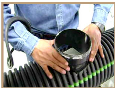
**Paso 5.** Introducir el Empaque por el barreno del tubo de atarjea. Sin soltar el Conector, flexionar un poco el Empaque para que quepa por el barreno e introducirlo al tubo de atarjea. Verifique que los bordes en forma de aleta quedan “hacia arriba” para que se puedan acoplar con la pared interna del tubo de atarjea.
