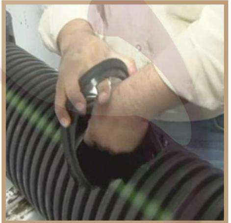
Flexione solo un poco el Empaque para que pase por el barreno y dentro del tubo acople Empaque y Conector.
