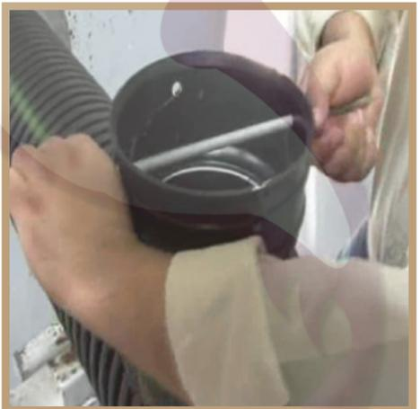
Gire hasta que el extremo del Conector coincida con el borde interno de la Campana y luego gire 3/4 de vuelta más.
