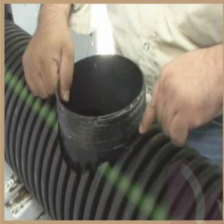
Asegúrese de que embonan las guías laterales del Conector con las ranuras del Empaque.
