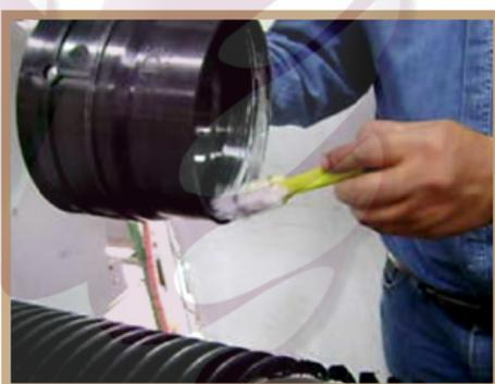
**Paso 4.** Introducir el Conector por el barreno del tubo de atarjea. Haga pasar el Conector por el barreno, pasando primero la brida integrada y por último la rosca.
