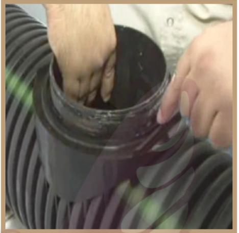
No suelte el Conector en ningún momento para evitar sea arrastrado por el flujo dentro del tubo. Asegúrese que las guías laterales del Conector embonen con las ranuras de la Silleta.
