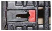
El clip de seguridad se fija junto al dispositivo Powerlok una vez cerrado. El clip queda al ras de la rejilla y no puede ser quitado.
