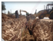
Figura 16. Colocación y compactación simétrica por capas.
