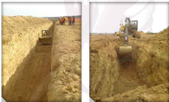
Figura 5. Excavación de la zanja.
