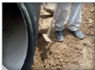
Figura 17. Herramientas para trabajos de acostillado.
