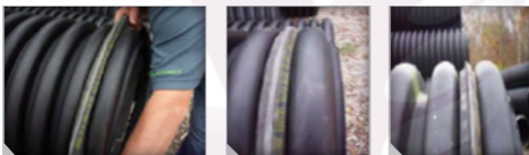
Figura 21. Colocación de empaques de valle.
