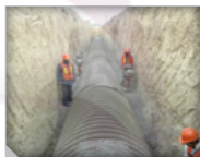
Figura 16. Colocación y compactación simétrica por capas.
