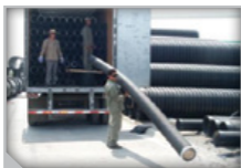
Figura 1. Descarga manual de tubería hasta 18 pulgadas.
