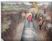
Figura 16. Colocación y compactación simétrica por capas.
