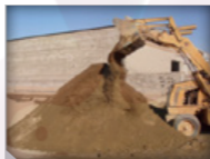
Figura 15. Humedad óptima al material de acostillado.
