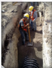
Figura 18. Compactación de relleno inicial.
