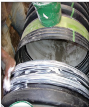
Figura 14. Colocación de lubricante.
