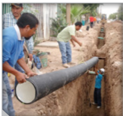
Figura 8. Bajado manual de tubería a la zanja.
