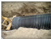
Figura 12. Empuje con maquinaria.
