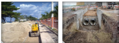
Figura 19. Compactación relleno final.
