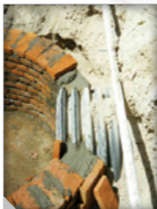
Figura 20. Conexión a pozo con empaques de valle.
