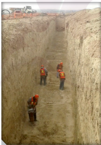
Figura 7. Compactación de encamado con equipo portátil.
