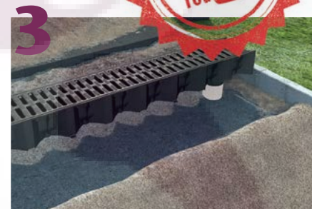
3 Perfore el canal en el espacio elegido para la descarga, y comience la instalación de los canales hacia aguas arriba.
