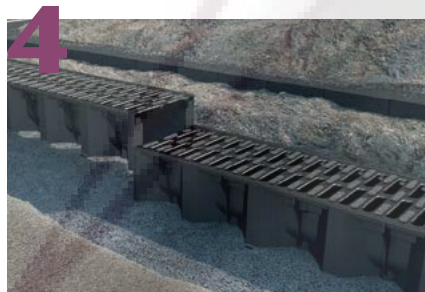
4 Continúe colocando los canales hasta terminar la línea proyectada. Recuerde que los extremos están machimbados.
