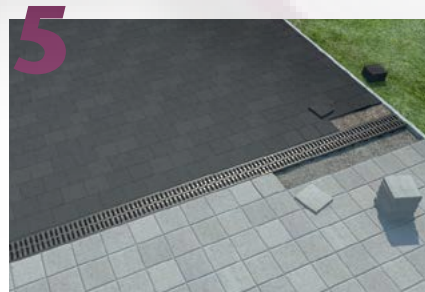
5 Coloque el concreto envolvente alrededor del canal hasta el nivel deseado. Después coloque el acabado final.
