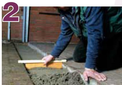
Coloque una base de 10 cm de concreto. Asiente el canal sobre la base (corte si se requiere).
