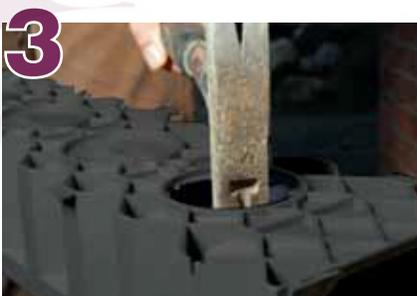
Rompa la base del canal en el lugar elegido para la descarga y coloque el adaptador inferior para la tubería; después conecte con un tubo PVC de 4" cédula 40.
