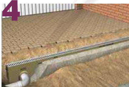
4 Inserta las rejillas en los canales. Para mantenerlas limpias puedes emplear cinta como protección.
