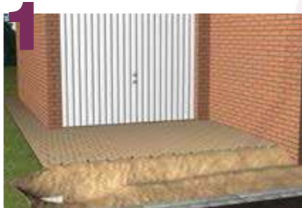
1 Excava el área apropiada para alojar el registro y los canales; se sugiere 10 cm por cada lado.
