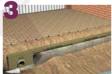
3 Coloca los canales a partir del punto de descarga. Revisa los niveles y sella las juntas.
