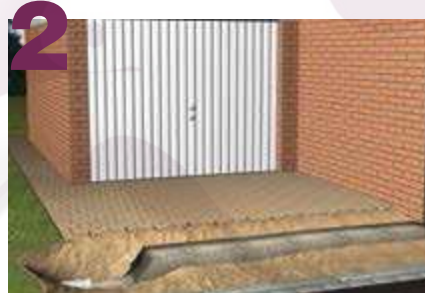
2 Coloca una cama de oncreto pobre de 30 cm de ancho por 10 cm de profundidad.
